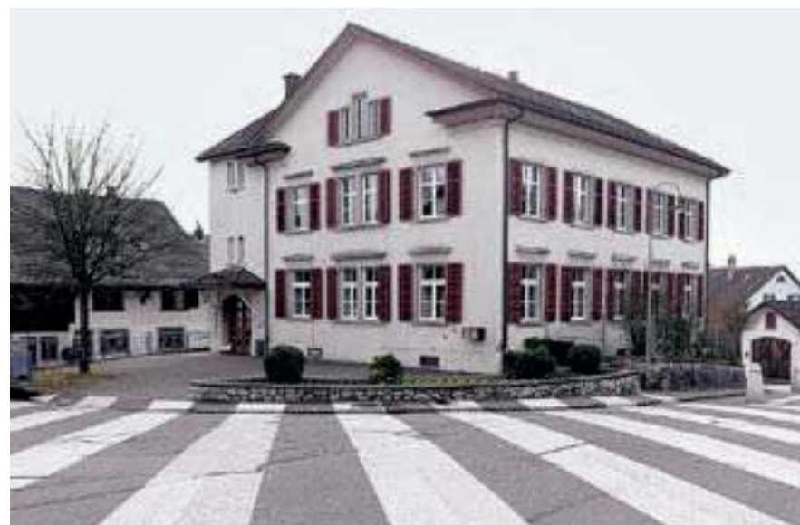
Der Kindergarten soll zur Kinderbetreuungsstätte umfunktioniert werden. Bild: mad
